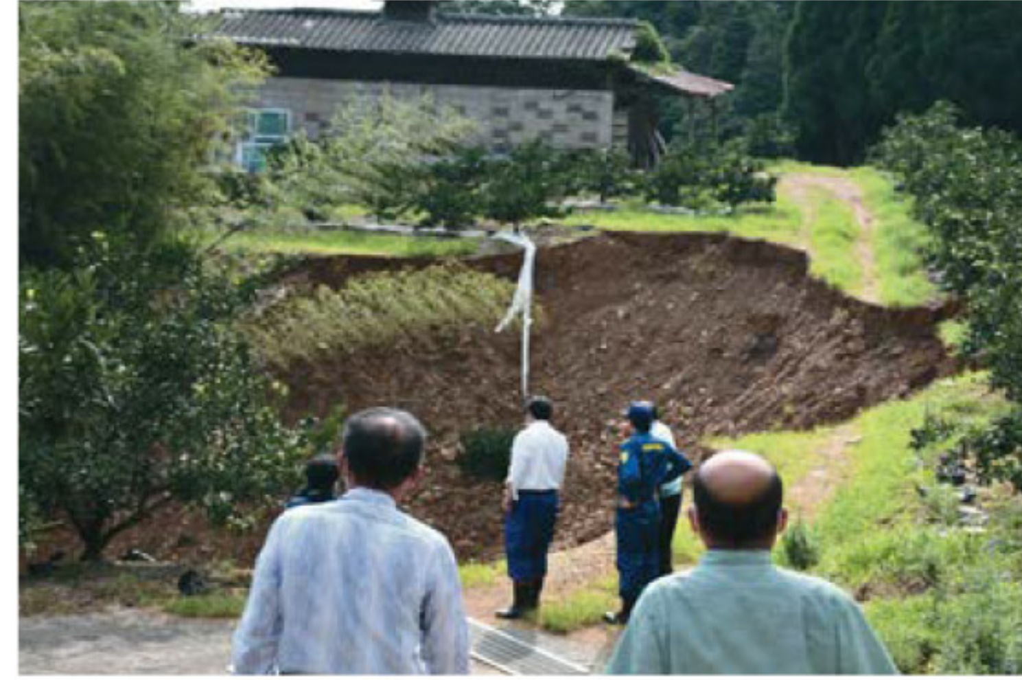
▲土砂崩れが起きたみかん園地
